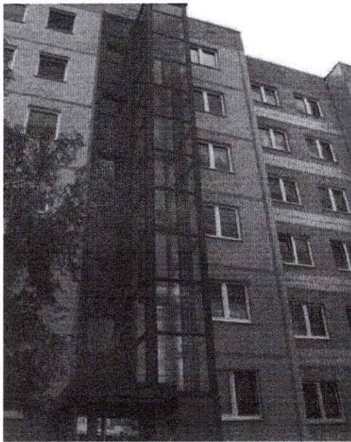
Рисунок 1.32. Приклади прибудови ліфта до сумісного зі сходовою кліткою приміщення
