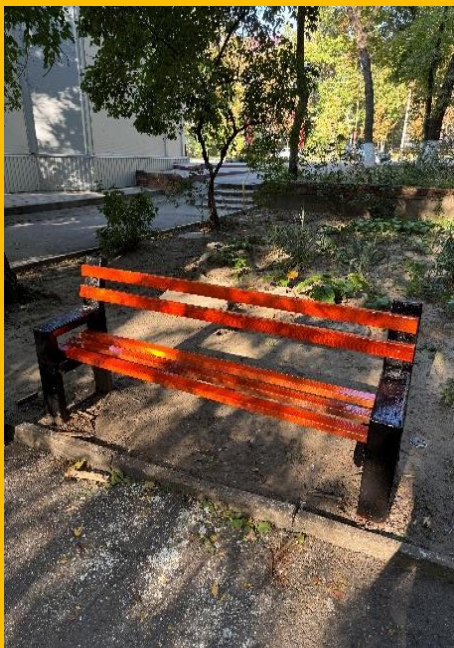
Встановлення лав за адресою вул. Шкільна, буд. 16.
