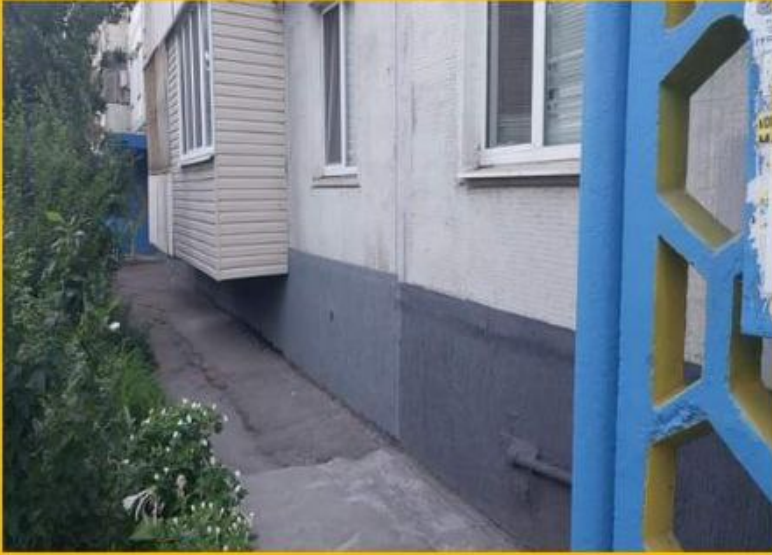
Ліквідація аварійного стану цоколя
